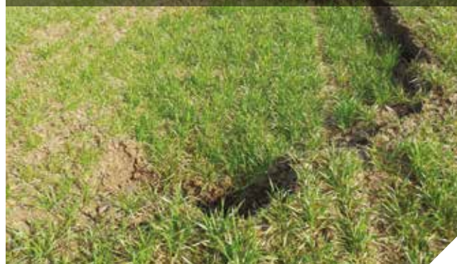
Exemple de zone d'infiltration par bétoire
