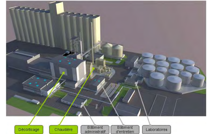
Investissement décorticage du tournesol et chaudière coques à Bassens (33)
